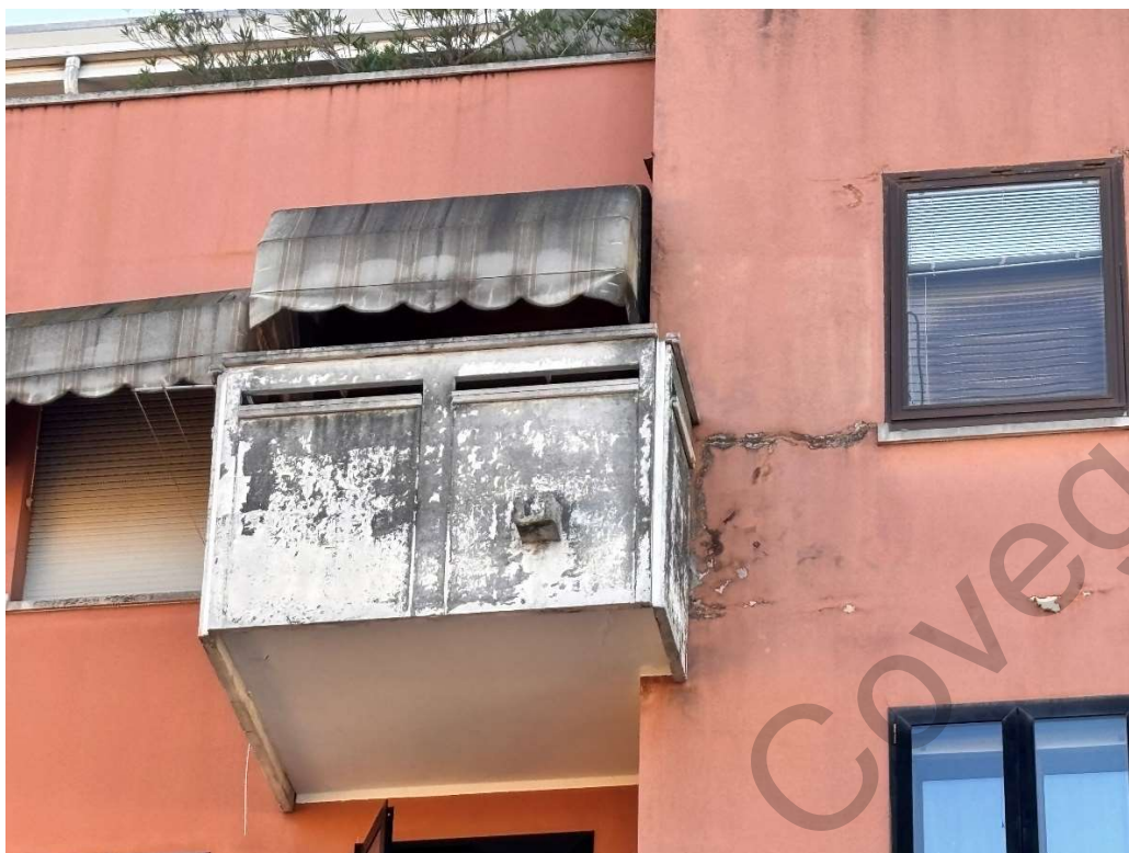
Ripresa fotografica n. 3 – dettaglio parete esterna nord-est fessurazioni ed ammaloramenti in parete
