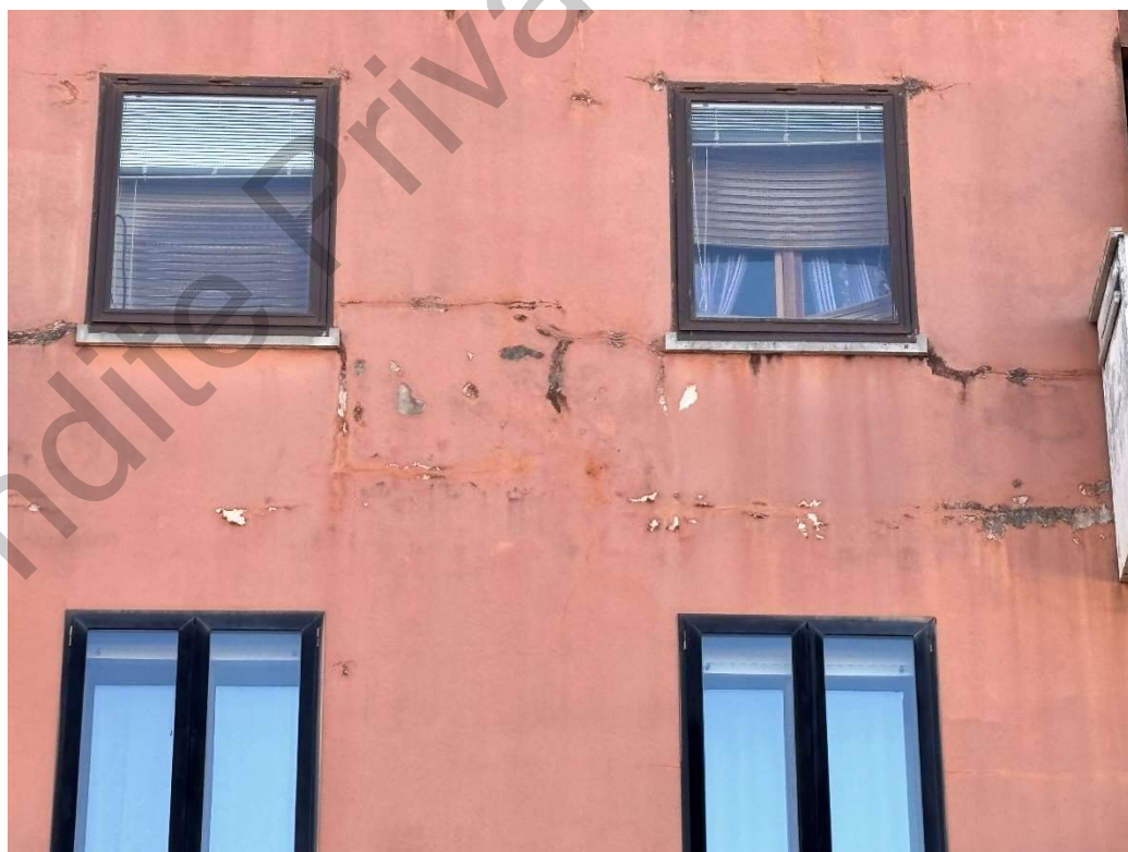
Ripresa fotografica n. 4 - dettaglio parete esterna nord-est fessurazioni ed ammaloramenti in parete
