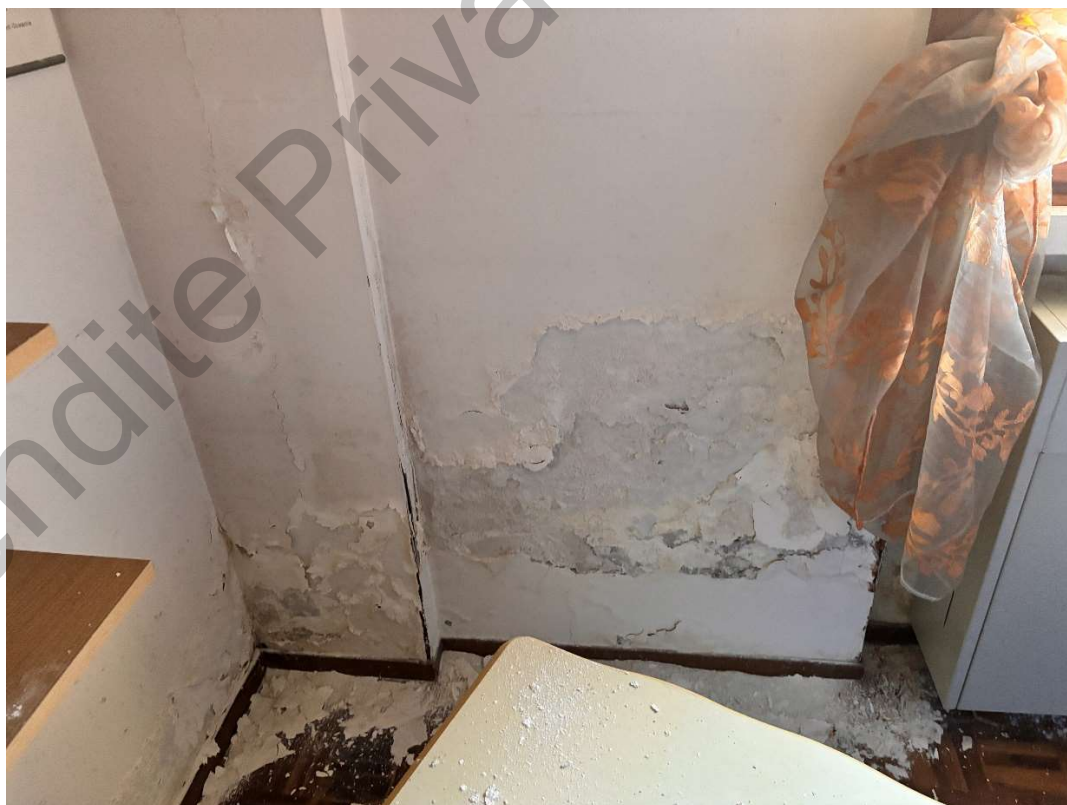
Ripresa fotografica n. 7 – parete interna muffe e sfarinamenti intonaco dovute ad infiltrazioni dalla parete esterna
