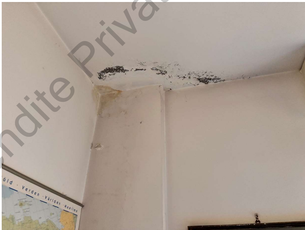
Ripresa fotografica n. 6 – soffitto interno muffe e sfarinamenti intonaco dovute ad infiltrazioni dal terrazzo superiore
