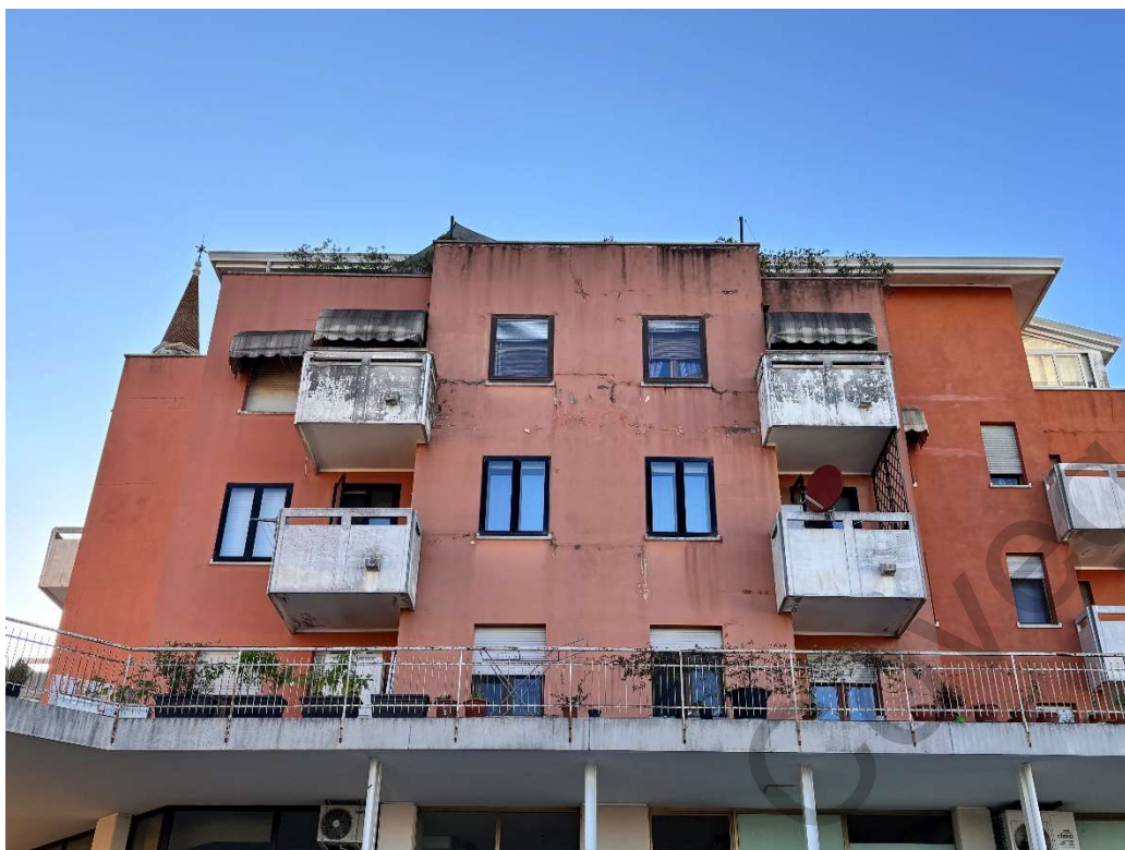
Ripresa fotografica n. 1 – parete esterna nord-est fessurazioni ed ammaloramenti in parete
